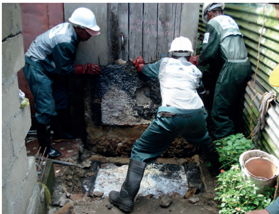
Ouverture de fosse septique.
